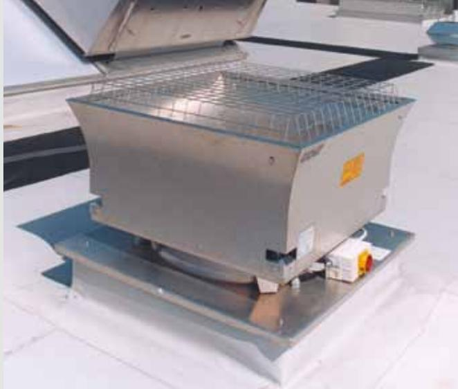
L'unité Colt Typhoon est un aérateur compact prévu pour l'extraction mécanique de l'air; il a une forme aérodynamique, c'est une construction basse et d'un faible poids.
